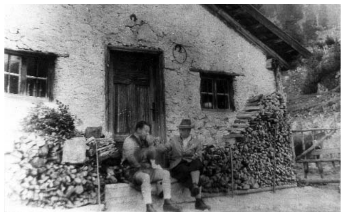
Die alte Almhütte musste beim Bau der neuen (um 1960) abgerissen werden, weil das der einzige lawinensichere Platz in diesem Bereich ist. (Anm. HK)
