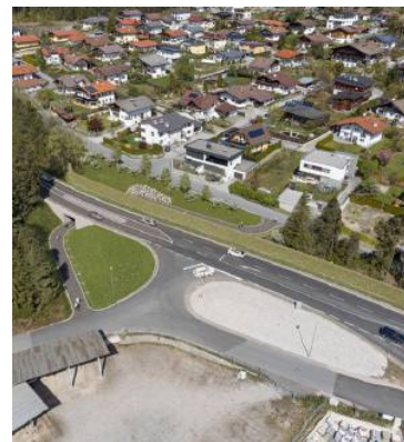
Am Obsteiger Ortseingang ist die Situation sehr komplex.
