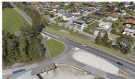
Vogelperspektive auf die künftige Geh- und Radwegunterführung in Obsteig bei der Ortseinfahrt im Norden.
