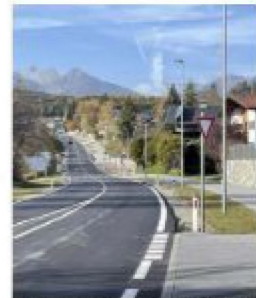
Der Rückbau der Ortsdurchfahrt ist abgeschlossen. Breite Geh- und Radwege führen nun durch Obsteig.
